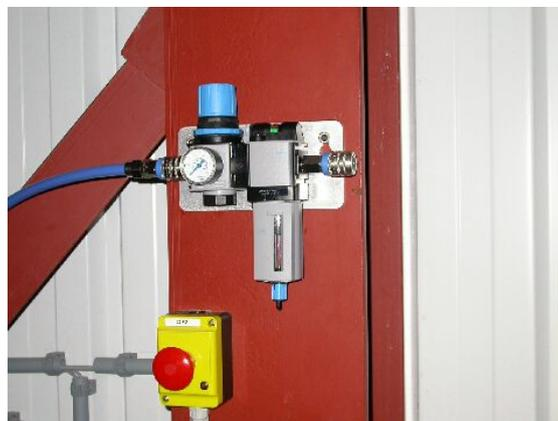
**Filtre équipé du pistolet au niveau coupole**
