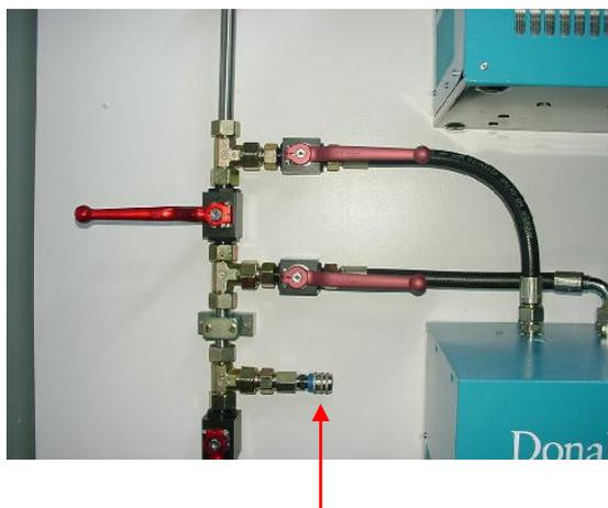
Raccordement du compresseur de secours
